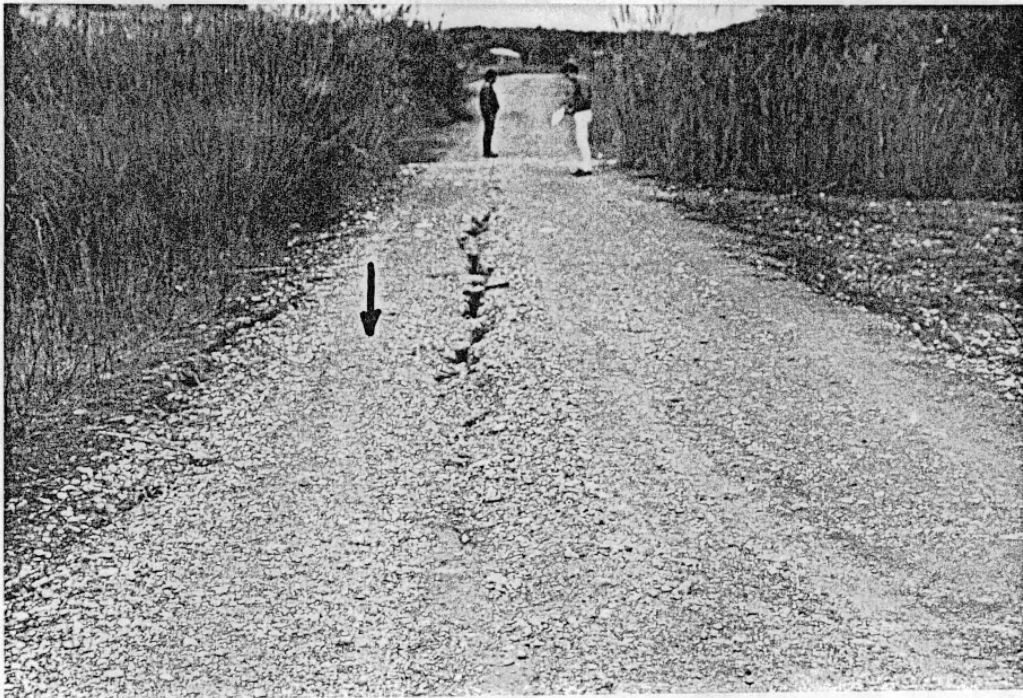
Εικ. 5. Εδαφικές διαρρήξεις διεύθυνσης NNA-BBΔ κατά μήκος του αγροτικού δρόμου Βαρθολομιού - Μπούκας. Οι διαρρήξεις έχουν άλμα της τάξης των 5-10 εκατοστών με αποτέλεσμα το ενδιάμεσο μικρο-τέμαχος να έχει ταπεινωθεί σε σχέση με τα εκατέρωθεν.
